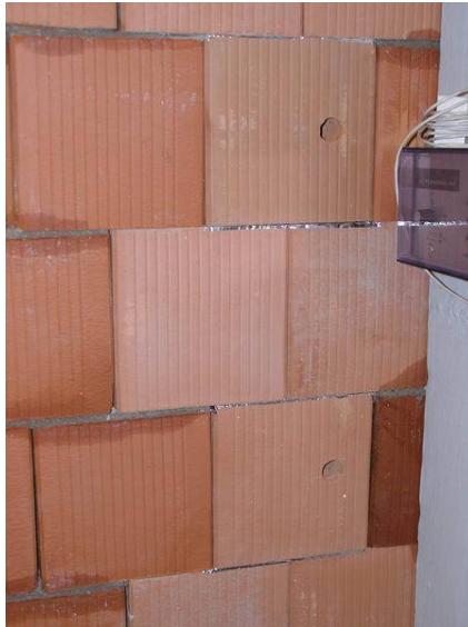
1. kép: Bal oldalon a normál, jobb oldalon a csiszolt téglából épített falazat
