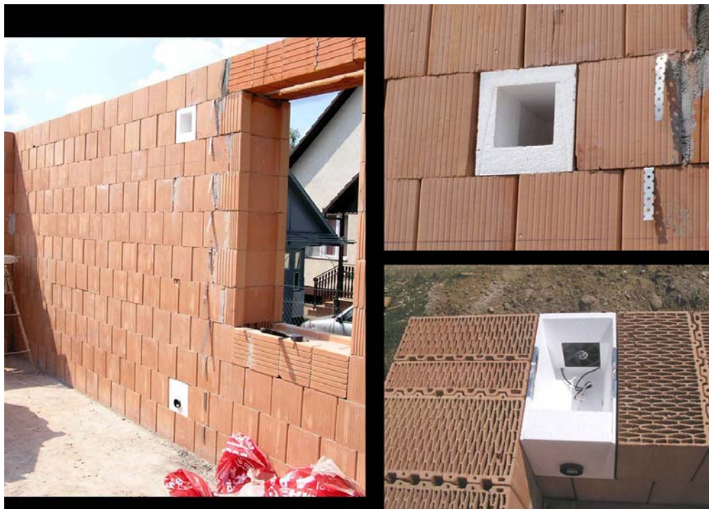
4. kép: A referencia-projekt szellőző elemeinek beépítése
