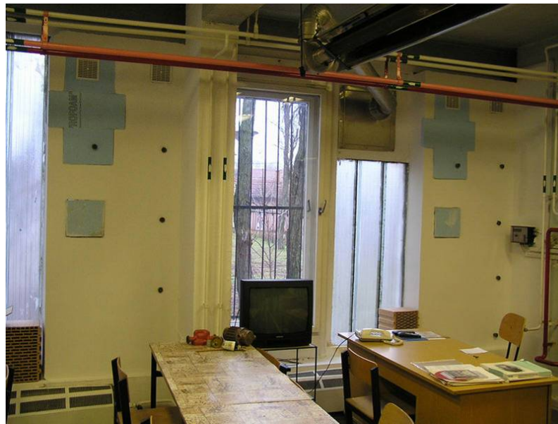
3. kép: Az egyetemi laboratóriumban megépített téglakürtők Porothem N+F, illetve HS falazatban
