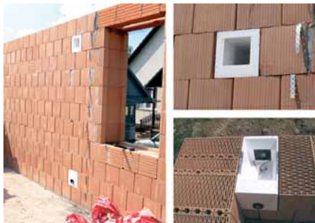
5. ábra. Családi ház szellőző-berendezése építés közben
