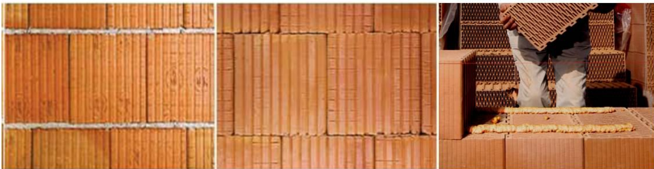
3. ábra Balra a hagyományos, középen a ragasztóhabarcsos, jobbra a DRYFIX Extra falazás
