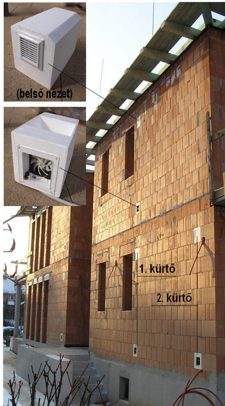
7. ábra Debreceni mintaprojekt építés közben
